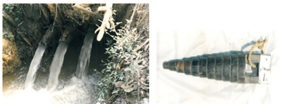
图7 傣族有压自由出流涵管分水(左)和配水量具“根多”(右)(诸锡斌1986年拍摄于西双版纳)
