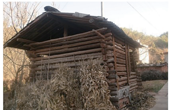
图10 云南武定县插甸镇的垛木房(诸锡斌2021年摄于武定插甸镇)
